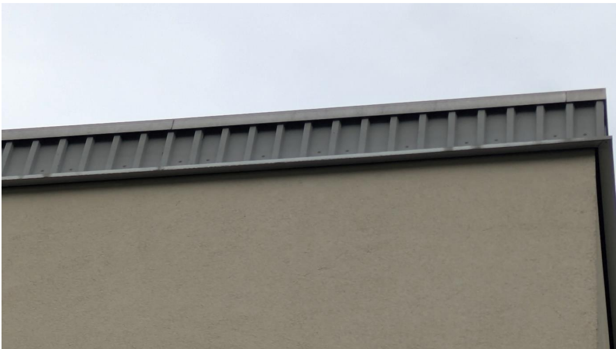
Abb.5: Abgeschlossenen Dachkonstruktion ohne Nutzungshinweise
